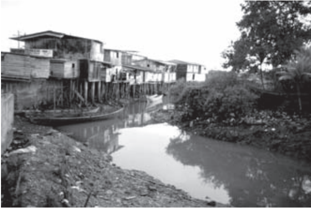
Foto 8. A pesar de que no están sobre la costa estas viviendas palafíticas se posan sobre terrenos con riesgo de inundación. Buenaventura. Foto Carlos Torres.
